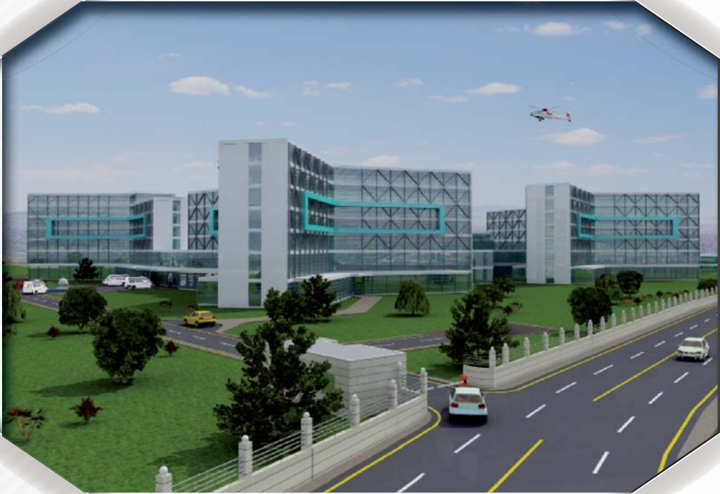
Bursa Şehir Hastanesi
